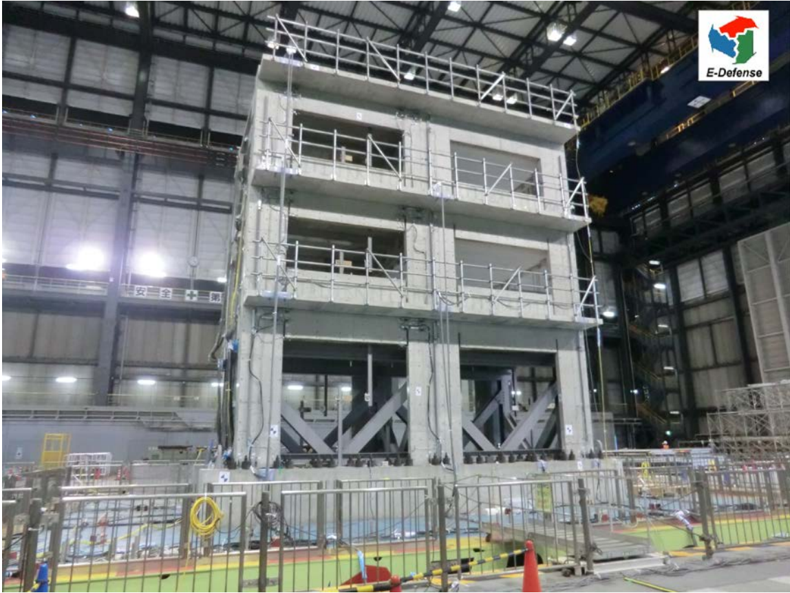
災害拠点となる役所建物を想定した3階建てのほぼ実物大の試験体
